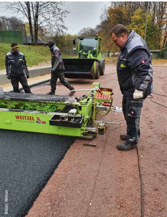
Einbau der elastischen Ecocept® Tragschicht
