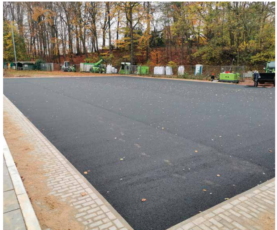
Elastische Ecocept® Tragschicht in Oelixdorf
